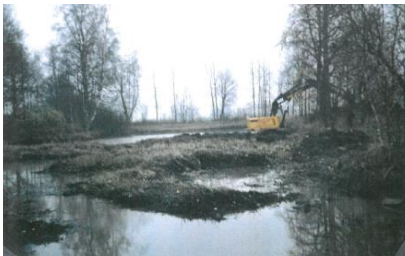
Graving og opprenskingsarbeidet i Langdammen den 25. oktober 1995. Foto: Olav Magnus Skulberg .
